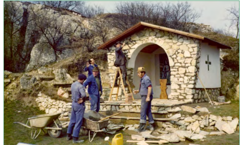
Kurz vor der Fertigstellung
